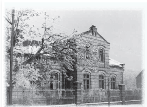
Biere, Haus von Hedwigs Eltern, Foto Winter 1940 (damals Dr. Marquardtstraße, später Ernst Thälmannstraße)
